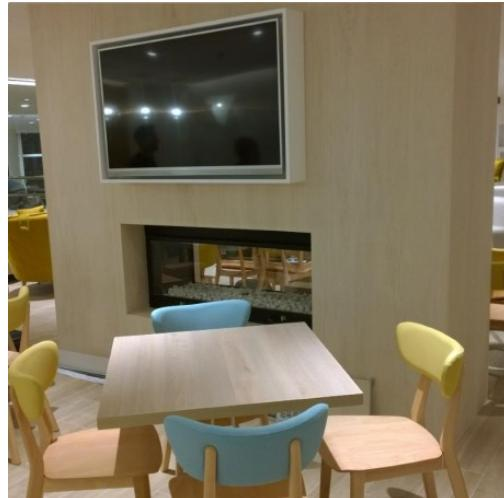
**Summary** Chimenea de Gas estanca de 145 cm. a dos caras modelo VT126S2RN. Ventilación superior. Funcionamiento a Gas Natural, potencia máxima de hasta 13,2Kw. Módulo de encendido manual. Frente de Cristal Bo...
