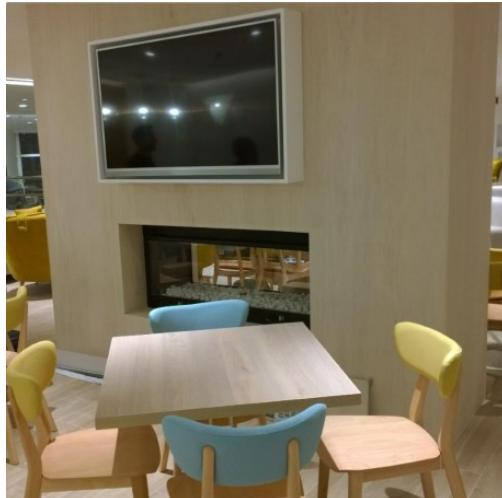
**Summary** Chimenea de Gas estanca de 145 cm. a dos caras modelo VT126S2RGN. Ventilación superior. Funcionamiento a Gas Natural, potencia máxima de hasta 13,2Kw. Módulo de encendido electrónico con regulación ...
